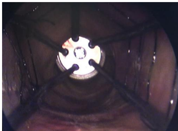
Figura 15: Espacio de trabajo habilitado
